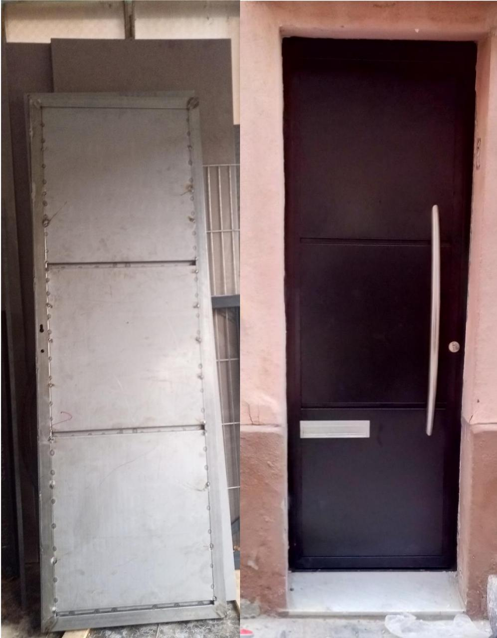
Puerta acceso vivienda (Badalona). Construida en hierro/inox con tejido ignífugo en el interior y con cerradura de 3 puntos y cilindro de seguridad Tesa ST6.
