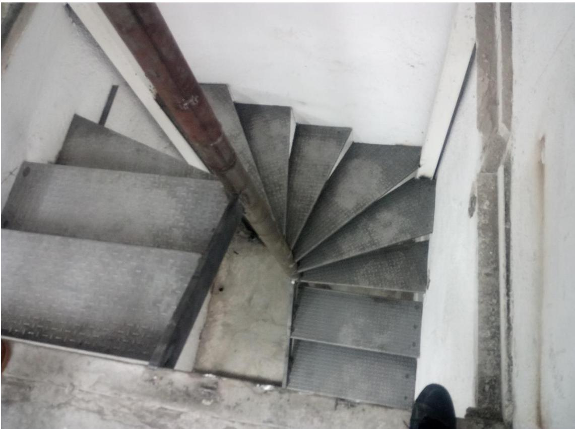
Escalera de caracol con eje descentrado y peldaños terminados en paredes. Diseñada en CAD y cortada a laser. (Estudio de grabación. Esplugues de Llobregat)
